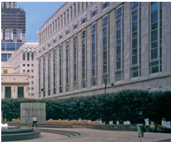
Façades et périmètres de sécurité
